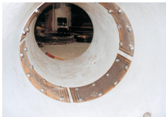
写真-4 内面補強(呼び径:1000)
