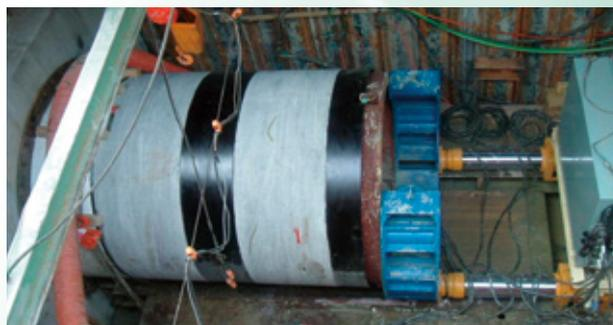
写真-1 先頭管(呼び径:2000)推進風景
